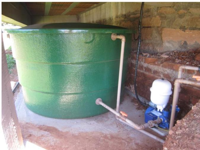
Para maior segurança, o quiosque recebeu novas instalações com vistas ao suprimento de água. São duas caixas de 1.000litros cada, acionadas de forma automática por uma bomba de água.
